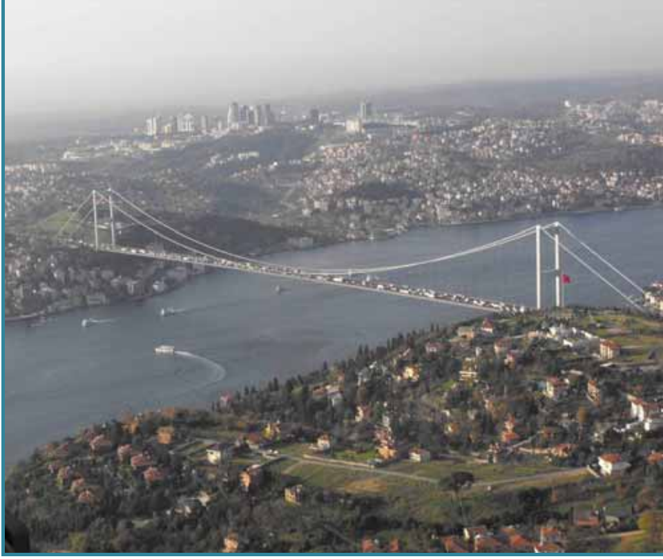
Resim 2: Boğaziçi Köprüsü, 2009 (İMECE)
